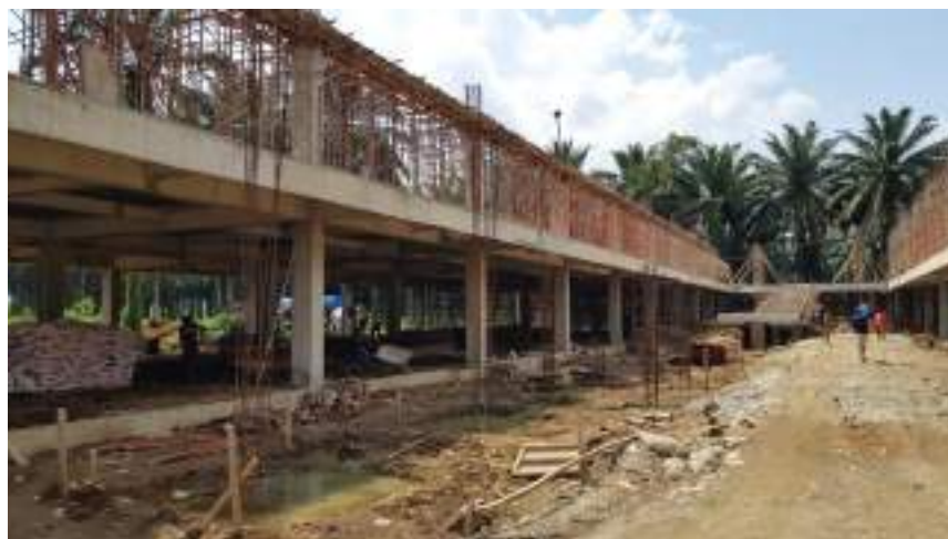
Gambar 30. Proses Pembangunan Gedung Fakultas Kehutanan Kampus USU
